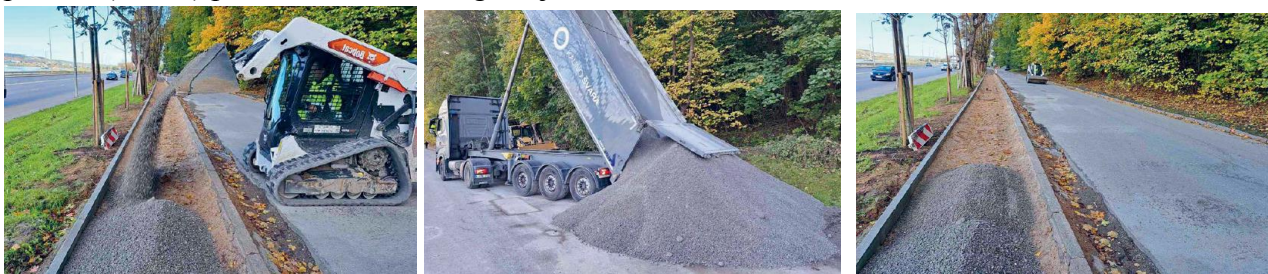
18 pav. Pelenų (šlako) panaudojimo kelių tiesime.
